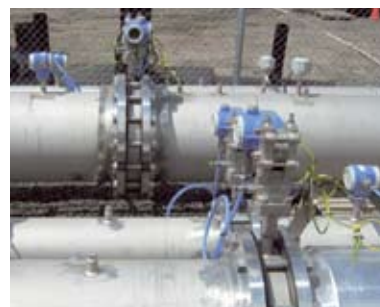
Deponiegasleitungen mit Deltatop Volumendurchflussmessung
