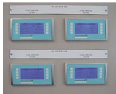
Applikationsmanager RMM621 rechnet die Energiemenge
